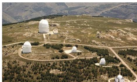
Die größte Kuppel des Calar-Alto-Observatoriums beherbergt das 3,5-m-Teleskop. CARMENES ist eines der Instrumente für dieses Teleskop.
